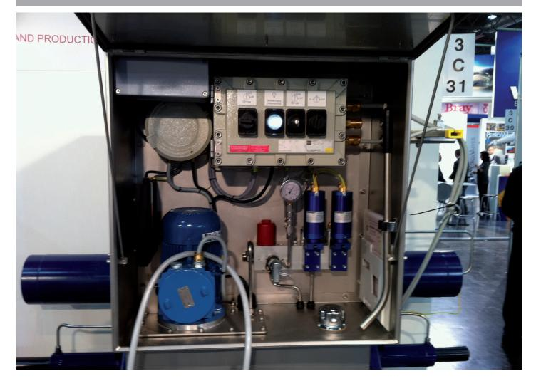
Hydrauliksteuerungen der FASEK Engineerung and Production GmbH (FASEK) kommen überwiegend in der Gasindustrie mit explosiver Atmosphäre in der Zone 1 zum Einsatz.
